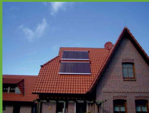
Einfamilienhaus in Meppen, Deutschland, Dachmontage, 160 Heat Pipe Röhren
