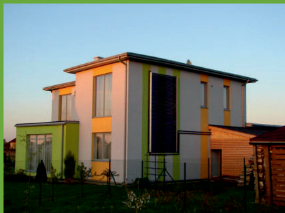
Einfamilienhaus in Kekava, Lettland, Fassadenmontage, 60 Direct Flow Powerrohre
