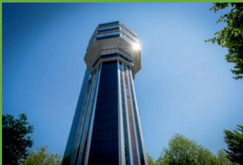
Hotel Aquatum, Radolfzell, Deutschland, Heizung, Warmwasser
