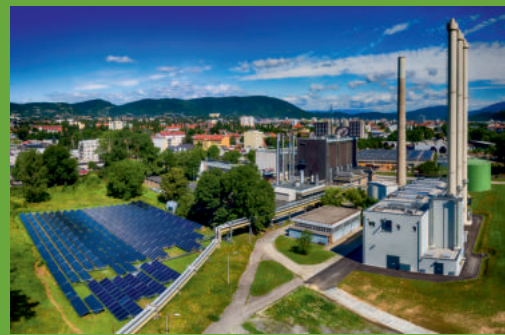
Fernwärmenetzwerk Graz, MEGA Kollektor
