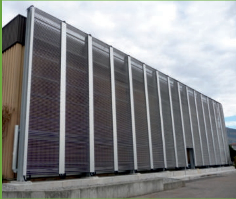
Obstverteilerzentrum Oberkirch, Solare Prozesswärme zum Kühlen
